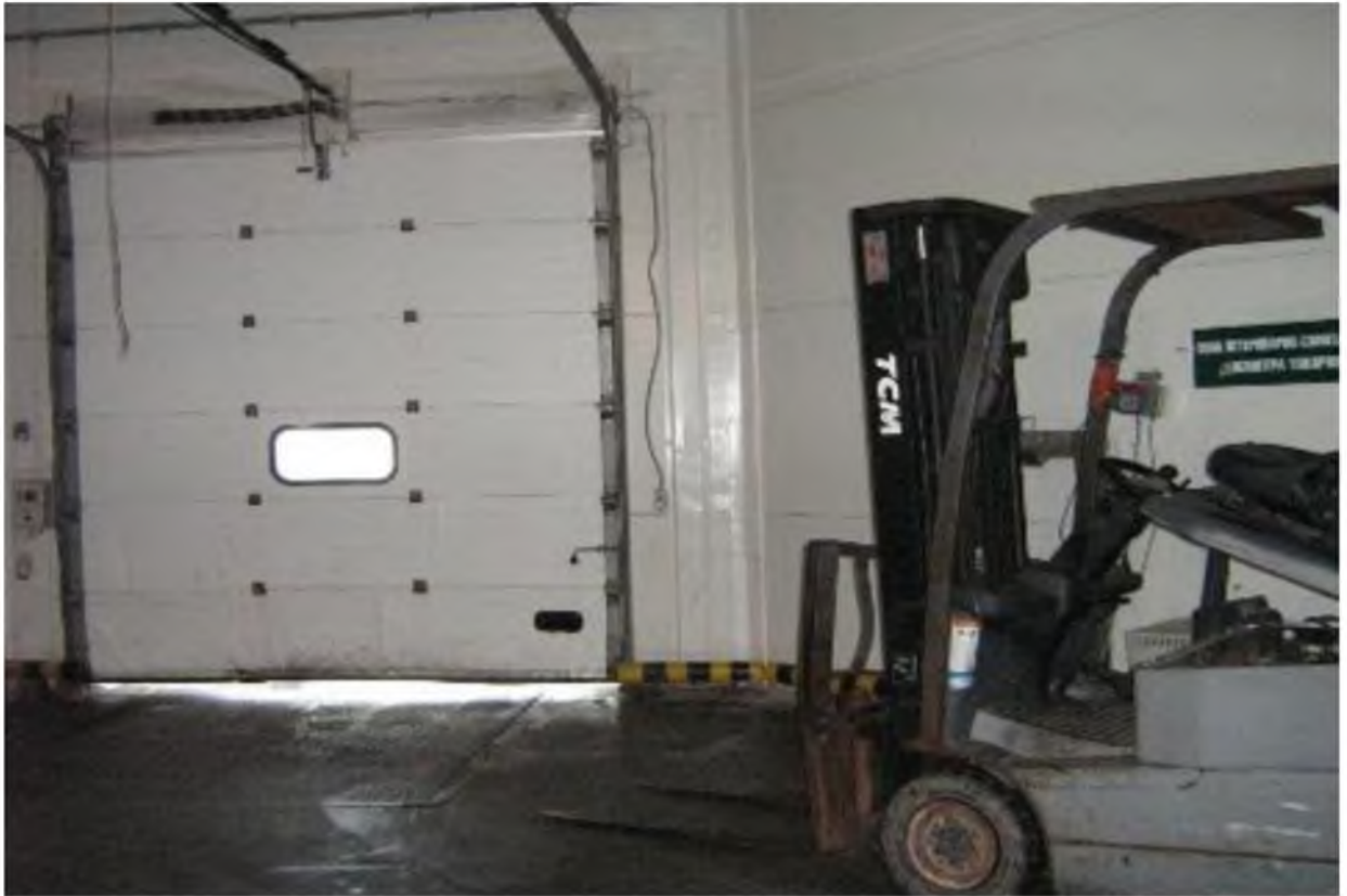
Фото № 1: досмотровая площадка - рампа.
